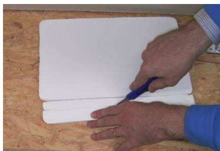
Slika3: ICECLAY rezanje plošče
